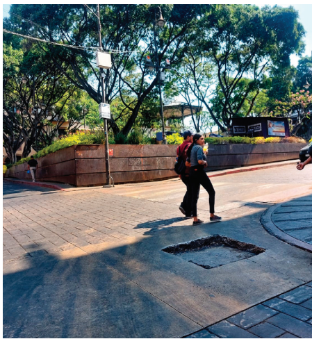
HUNDIMIENTO DE UNA Tapa de registro justo en el paso peatonal, con profundidad de 25 cm aproximadamente, en la calle Galeana esquina con Gutemberg, representa un riesgo para los peatones.
