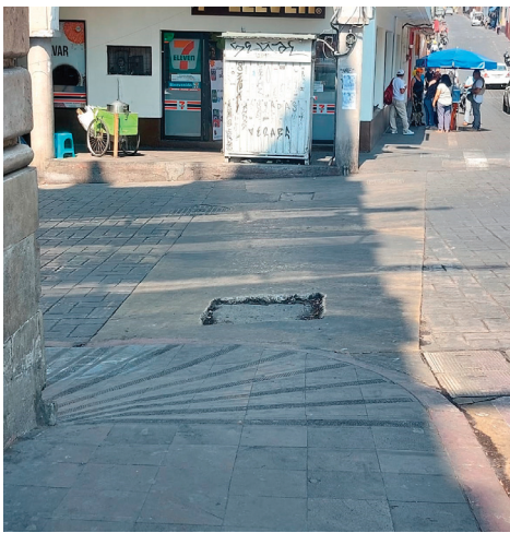
HUNDIMIENTO DE UNA Tapa de registro justo en el paso peatonal, con profundidad de 25 cm aproximadamente, en la calle Galeana esquina con Gutemberg, representa un riesgo para los peatones.
